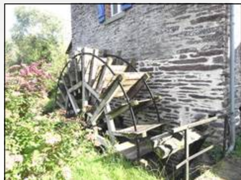
Le moulin de Cramoux à BREAL-SOUS-MONFORT (35)
