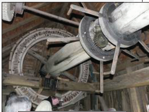
Commande manuelle « berton » des ailes du moulin à vent d'Ymonville (28)
